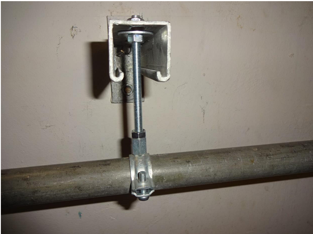
Bild 2: Bezugsmessung: DÄMMGULAST®, „Typ 1“, starrer Anschluss ohne Dämmelement
