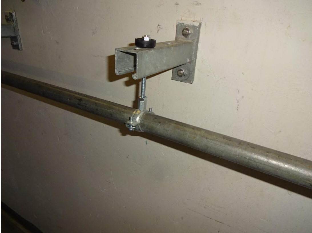
Bild 3: Messung 1: DÄMMGULAST® „Typ 1“, entkoppelter Anschluss mit Dämmelement
