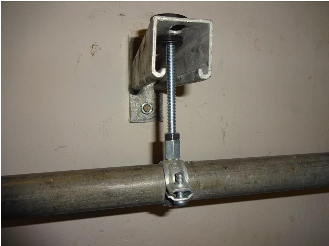
Bild 4: Messung 1: DÄMMGULAST® „Typ 1“, entkoppelter Anschluss mit Dämmelement
