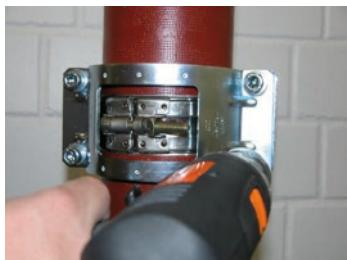
DE Schrauben wechselweise über Kreuz mit vorgeschriebenem Anzugsdrehmoment festziehen
