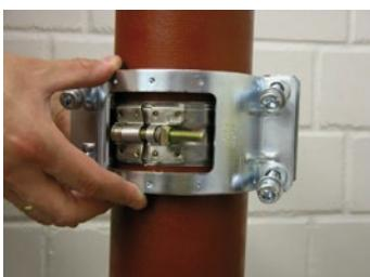
DE Sicherungskrallensegmente über den Rohrverbinder stülpen. Achtung: Krallen dürfen nicht auf den Schellenkörper drücken!
