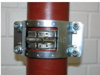
DE Alle Schrauben mit Unterlegscheiben unter dem Schraubekopf in die Krallensegmente einsetzen und locker verschrauben. Achtung: Die Unterlegscheiben dürfen auf keinen Fall weggelassen werden!
