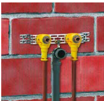
Waschtischinstallation: Alles genau auf Stichmaß montiert
